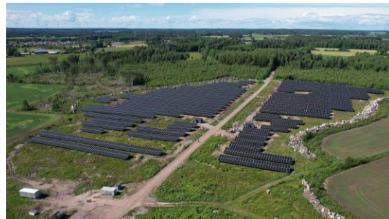
Töreboda, ca 10 hektar, effekt om 3 MW, driftstart 2023 (marktytor köpta av Töreboda kommun)
